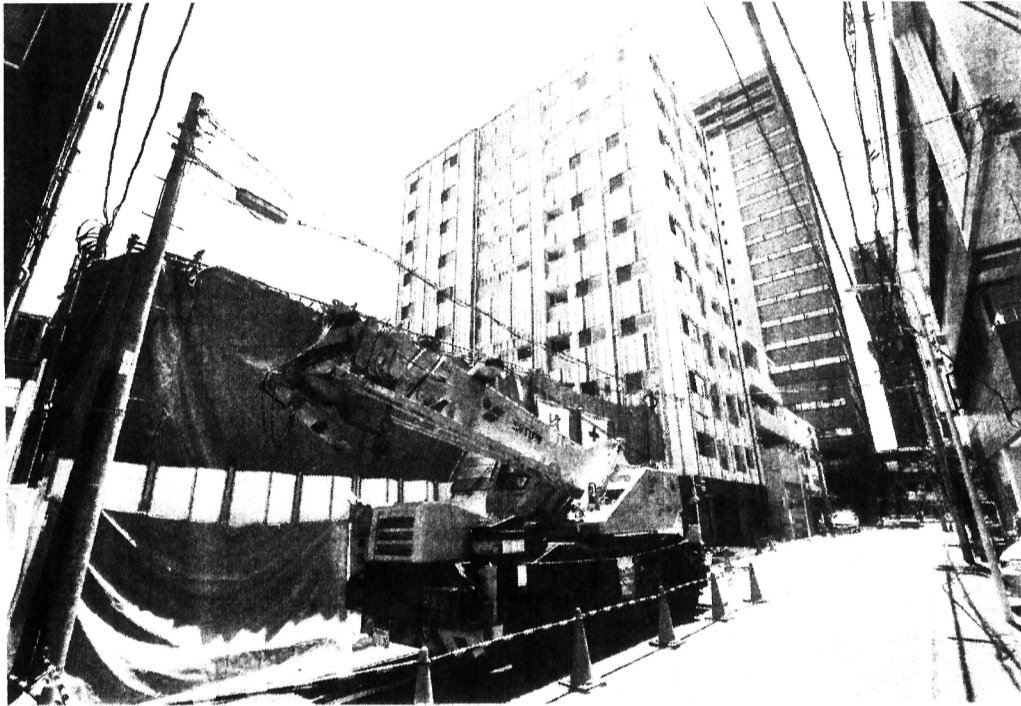
グローバル住販が建設中の「グロウス日本橋浜町」。隣の建物は間もなく入居が始まる「ウィルローズ日本橋浜町 sui」。どちらも完売している。首都圏の中でも東京都都区部のマンション人気は高い
